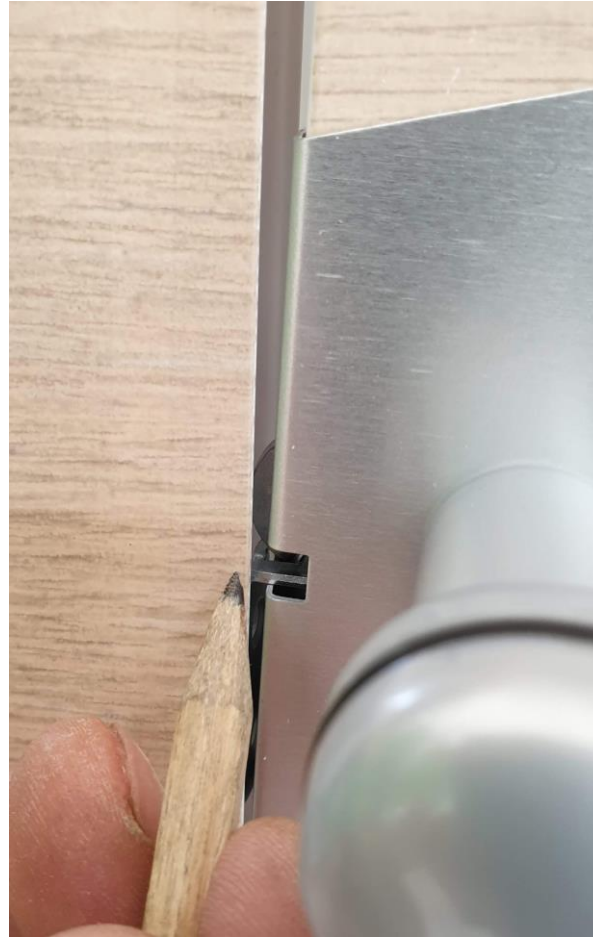
12. Jelölje át a magasságát a nyitó oldali függőleges profilra.
